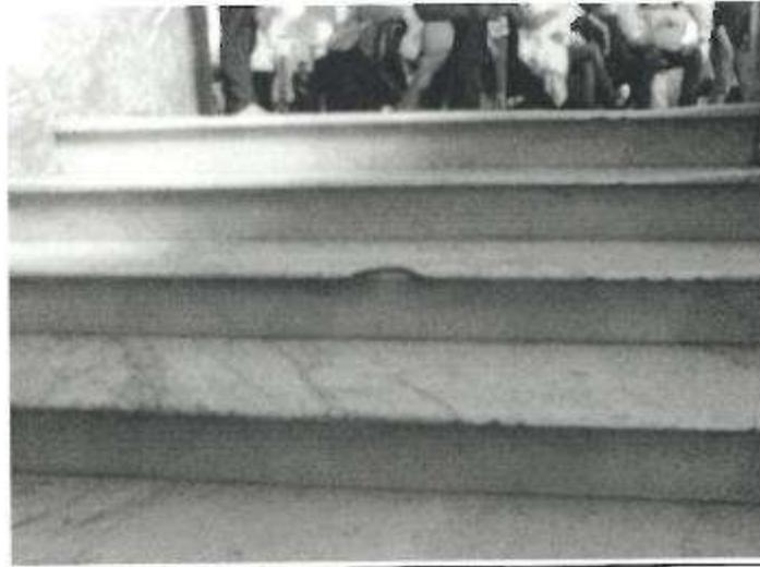
**BALDOSAS DE MARMOL QUEBRADAS, DESGASTE DE ESPESOR DE LAS PIEZAS.**
