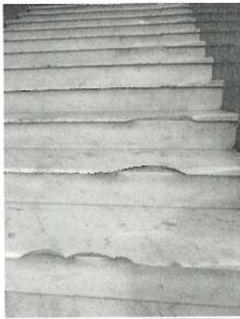
**VISTA FOTOGRAFICA APRECIANDOSE BALDOSAS DETERIORADAS, QUEBRADAS, FALTA DE FRAGMENTOS Y DESGASTE DE PIEZAS EN SU ESPESOR**
